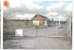
2 Vue sur l'entrée du site et les installations de SUEZ
