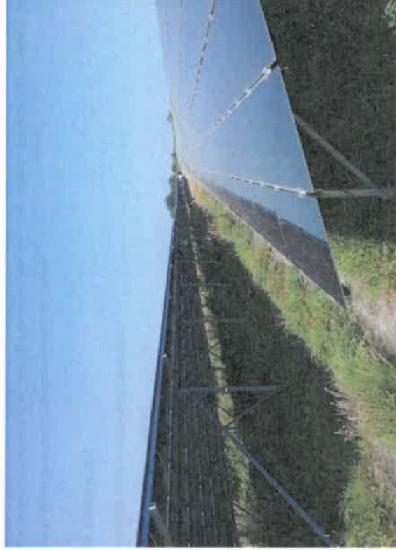
Exemple de structures porteuses
