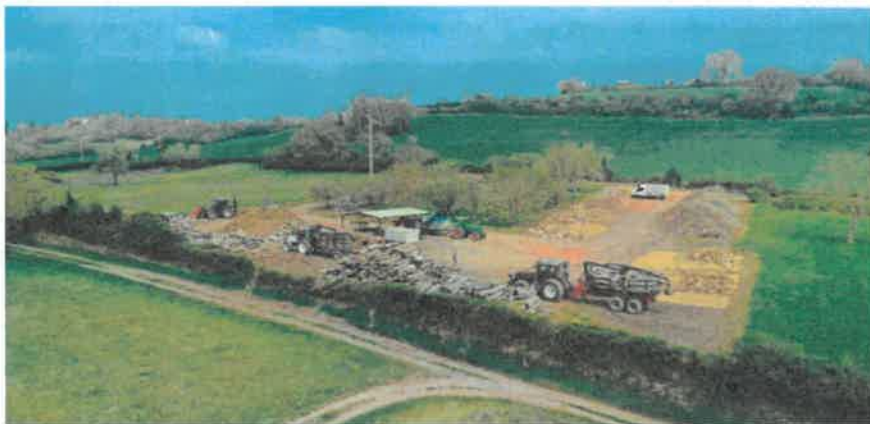
Vue de l'emprise foncière « avant » la construction du bâtiment de stockage communiquée par le porteur de projet.
