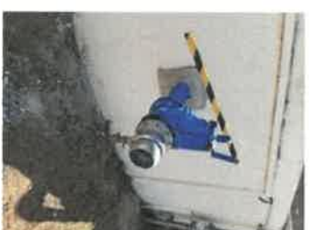
Mise en place d'une vanne et d'un dispositif de pompage pour déshydrater les boues dites « Covid » au bassin de l'habitats à la station d'épuration de Saint Amand Montrond
