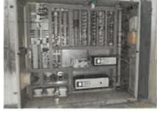
Renouvellement de la carte de commande du variateur de la pompe à boues à la station d'épuration de Saint Amand Montrond
