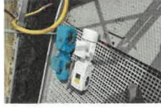
Renouvellement du réducteur de la vis du tamis des refus de dégrillage à la station d'épuration de Charenton Du Cher
