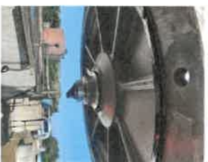
Renouvellement de l'axe principal d'une turbine d'évaporation à la station d'épuration de Saint Amand Montrond
