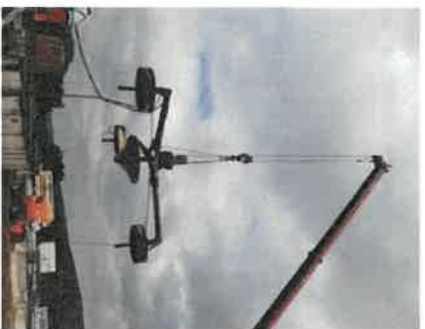
Renouvellement de l'axe principal d'une turbine d'évaporation à la station d'épuration de Saint Amand Montrond
