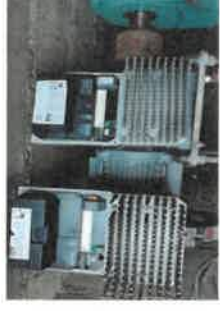
Renouvellement de la carte de commande du variateur de la pompe à boues à la station d'épuration de Saint Amand Montrond
