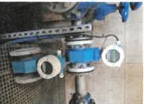
Renouvellement du débitmètre sortie des matières de vidange à la station d'épuration de Saint Amand Montrond
