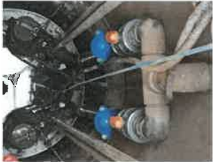
Renouvellement des accessoires hydrauliques au poste de relèvement rue de Valmy à Saint Amand Montrond
