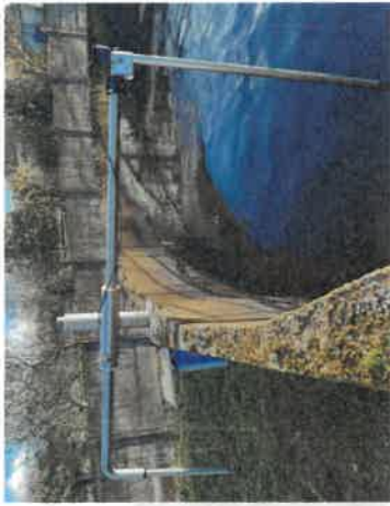
Renouvellement du support de la sonde Rédox à la station d'épuration d'Orval
