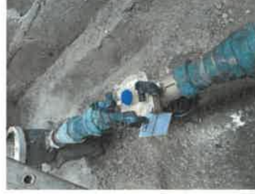
Renouvellement du disjoncteur sur le réseau d'eau potable de la station d'épuration de Saint-Amand Montrond
