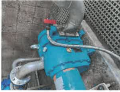
Renouvellement de la pompe de transfert des matières de vidange à la station d'épuration de Saint Amand Montrond
