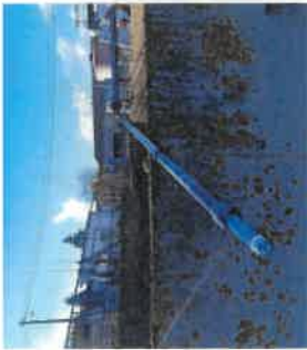
Renouvellement du support de la sonde Rédox à la station d'épuration d'Orval
