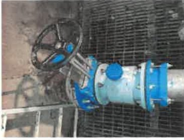
Mise en place d'un débitmètre au poste de relèvement rue de Billeron à Saint-Amand-Montrond
