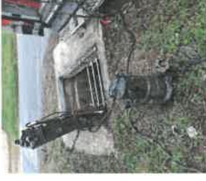
Renouvellement d'une pompe au poste de relèvement rue du Moulin des Farges à Orval
