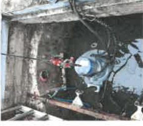
Renouvellement d'une pompe au poste de relèvement rue du Moulin des Farges à Orval
