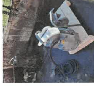
Renouvellement d'une pompe au poste de relèvement rue du Moulin des Farges à Orval
