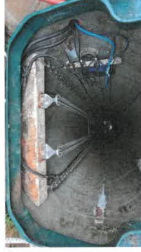
Renouvellement de l'hydraulique et de l'ensemble des accessoires au poste de relèvement Le Moulin à Orval
