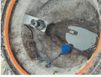
Mise en place d'une sonde de trop plein sur le réseau d'eaux usées en entrée de la lagune d'Orcenais
