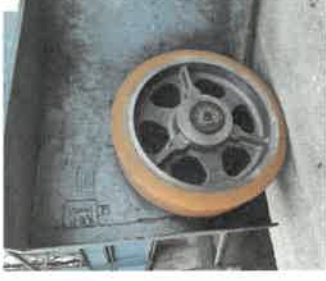
Renouvellement de la roue du pont radieux du clarificateur à la station d'épuration de Charenton Du Cher
