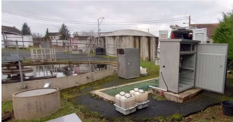
Renouvellement du préleveur de sortie à la station d'épuration d'Orval
