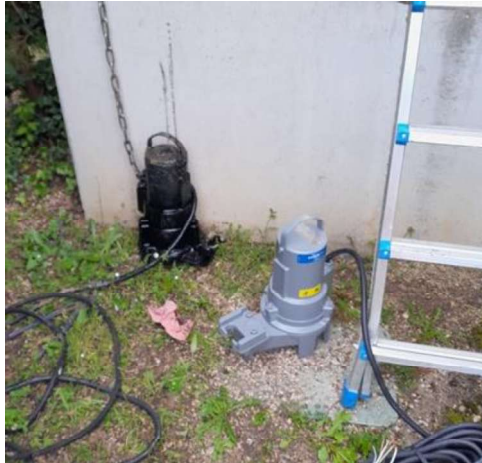
Renouvellement d'une pompe au poste de relèvement rue du Moulin à Orval
