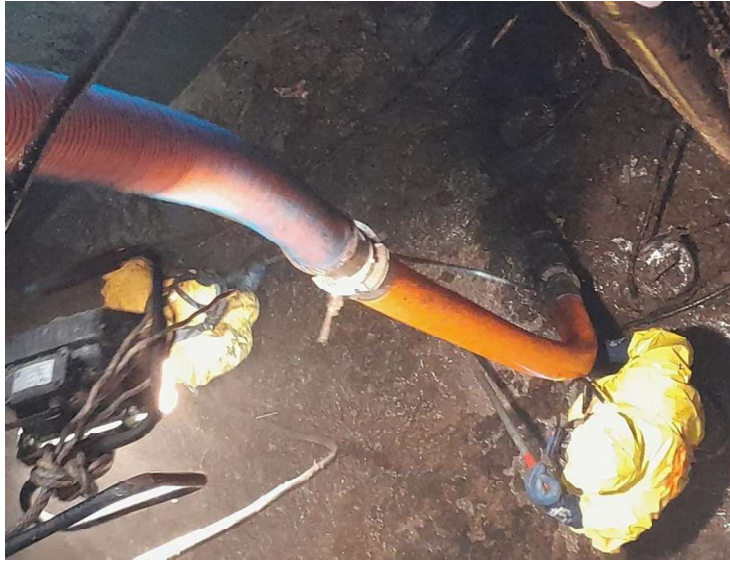
Nettoyage du poste de relèvement rue de Billeron à Saint Amand Montrond pour la mise en place d'une désodorisation
