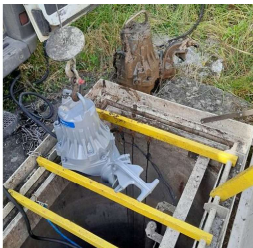
Renouvellement d'une pompe au poste de relèvement rue Séjourné à Charenton Du Cher
